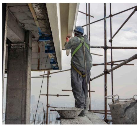
سیمان سفید نمای جنوبی طبقه ۱۸ در فاز یک پروژه
