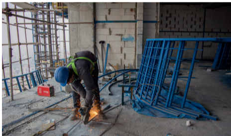
برش کاری نبشی قوس نمای غرب طبقه ۱۹ از فاز یک
