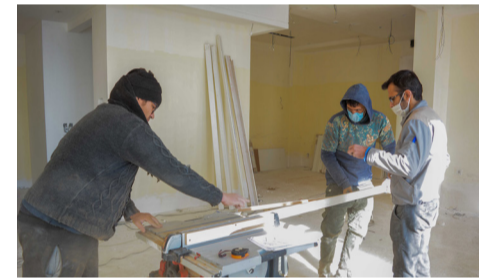
برش کاری و ساخت کمد طبقه ۱۸
