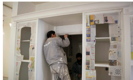
اصلاحیه درب‌ها در طبقه ۱۵
