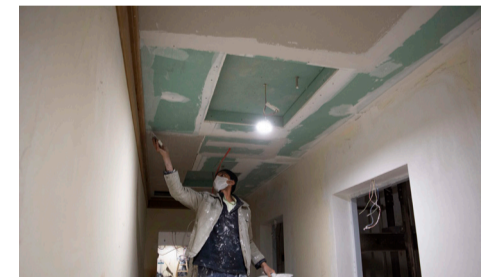
بنتون کثاف سقف راهرو طبقه ۱۳
