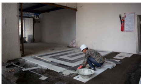
سنگ کاری کف ورودی دفتر اداری در طبقه همکف
