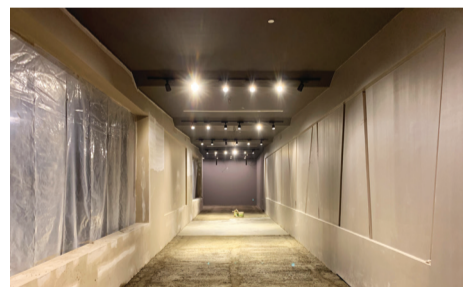
آماده‌سازی سالن بولینگ و نصب تجهیزات و ماشین‌آلات در طبقه منفی ۵
