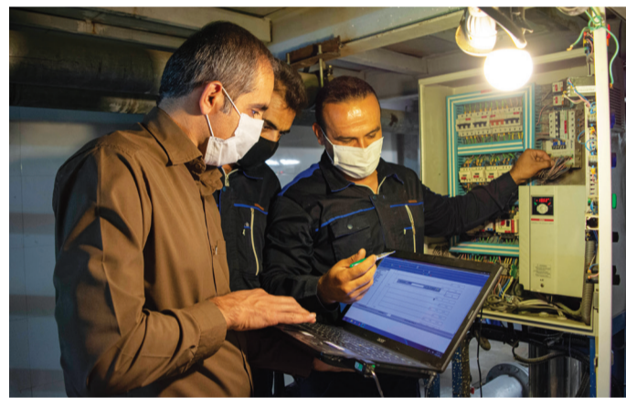
تعویض کنترلر فشار و اصلاح برنامه‌نویسی پمپ پمپ آب‌رسانی
